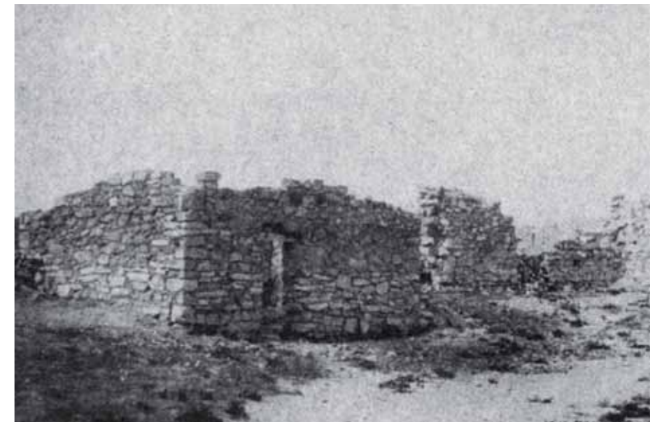
Aspecto de los restos de la casa que sirvió de prisión a Hidalgo en Baján.
